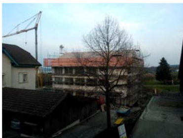
Construction d'un bâtiment de conseil spécialisé au CCF
