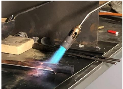
Construction de tuyaux
